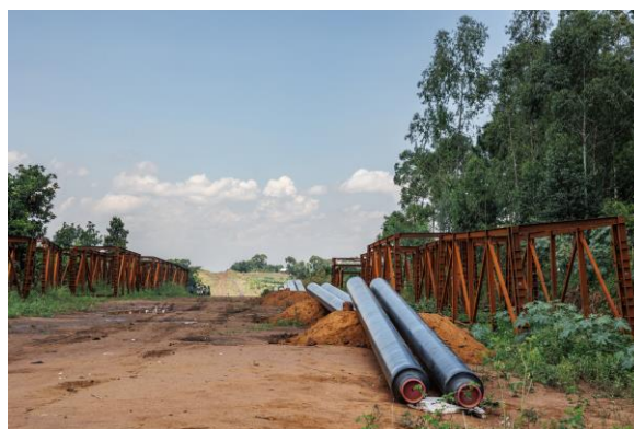
Travaux sur l'oléoduc à Hoima, en Ouganda (Jjumba Martin/Global Witness)
