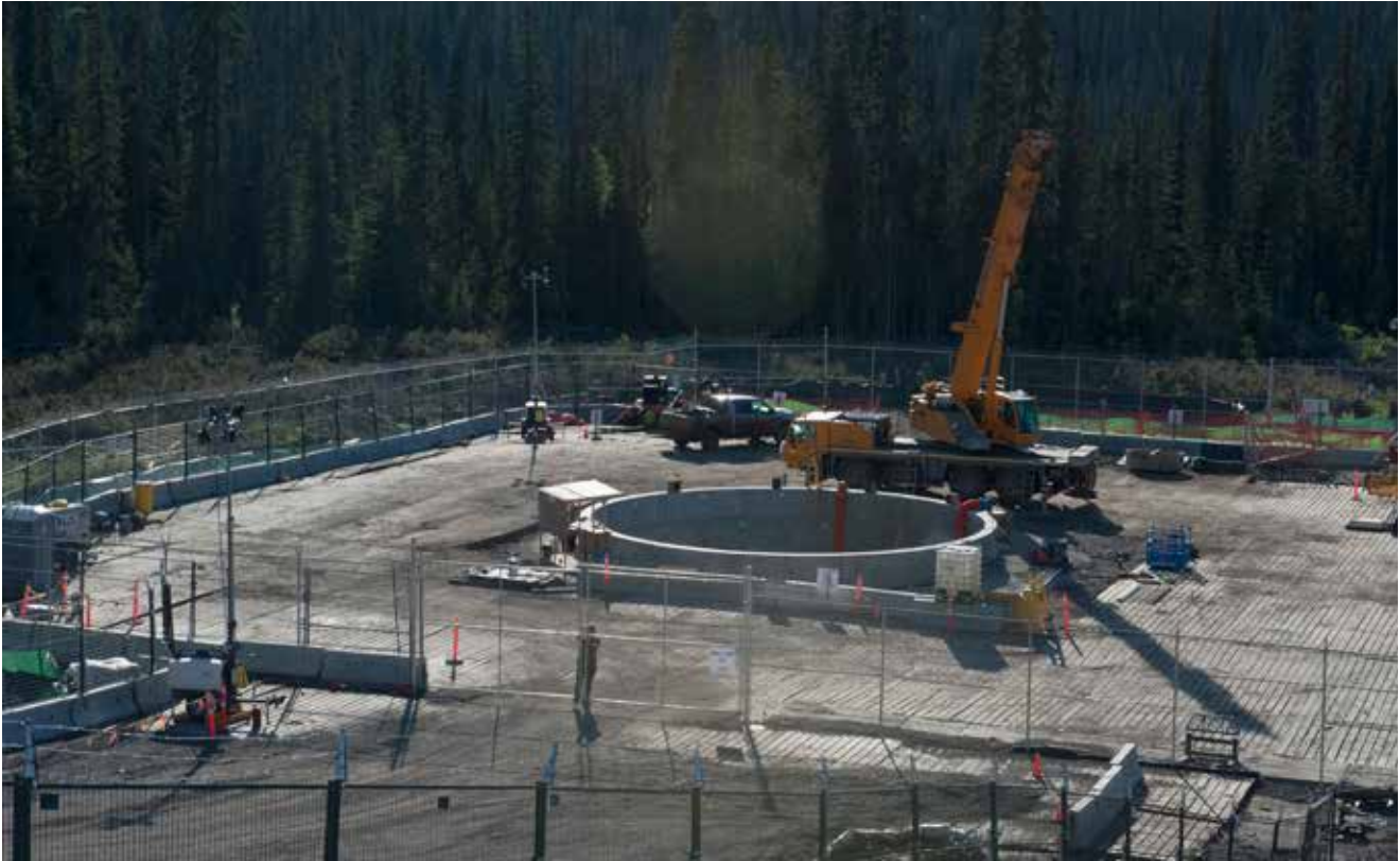
Coastal GasLink se preparando para obras de perfuração sob o rio Wedzin Kwa. Cedar George-Parker, da Primeira Nação de Tsleil-Waututh, cantou para tentar preparar os participantes para o choque com a escala do projeto. Matt Simmons / The Narwhal
