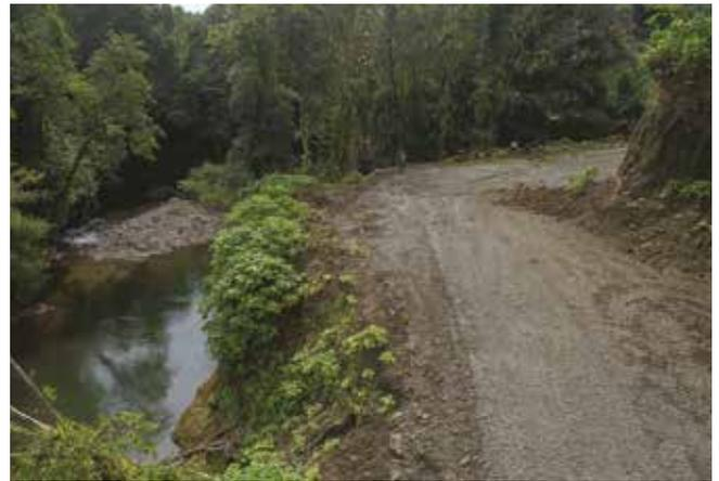
泰莫图省的一条伐木道路，它太靠近溪流，从而违反了《采伐操作规范》。按照《规范》，小溪两侧25米范围内、沟渠两侧10米范围内不得伐木。溪流被定义为每年有流水超过半年，而沟渠每年有流水不到半年。照片中的道路距离溪流明显不到10米。2018年7月。南纬10.678，东经165.934 ©Alessio Bariviera
