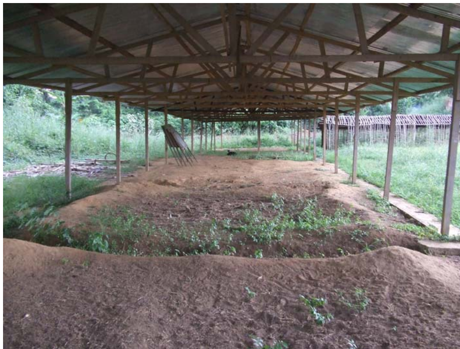
Photo 34. Ecole en construction depuis 4 ans, Yafunga
