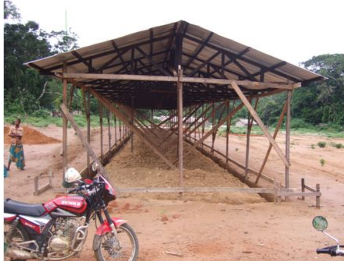
Photos 28, 29. Ecole réhabilitée par la société CFT à Kisasi
