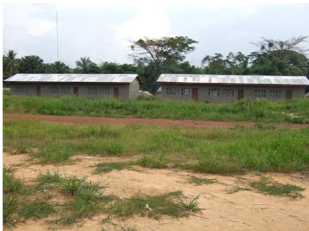
Photo 25. Ecole construite par TRANS-M
