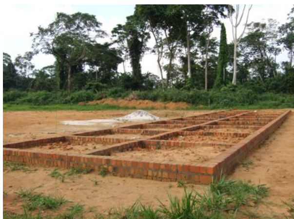
Photo 22 « Construction en cours » (TRANS-M)
