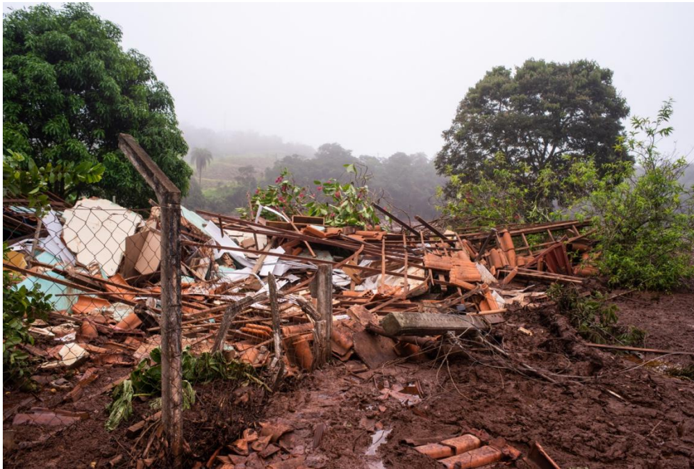
淡水河谷在巴西布鲁马迪纽(Brumadinho)的一座尾矿坝溃坝后，一栋房屋的残砖碎砾滑入了尾矿泥沼中。© 卢卡斯·尼诺 (Lucas Ninno) / 盖蒂图像 (Getty Images)
